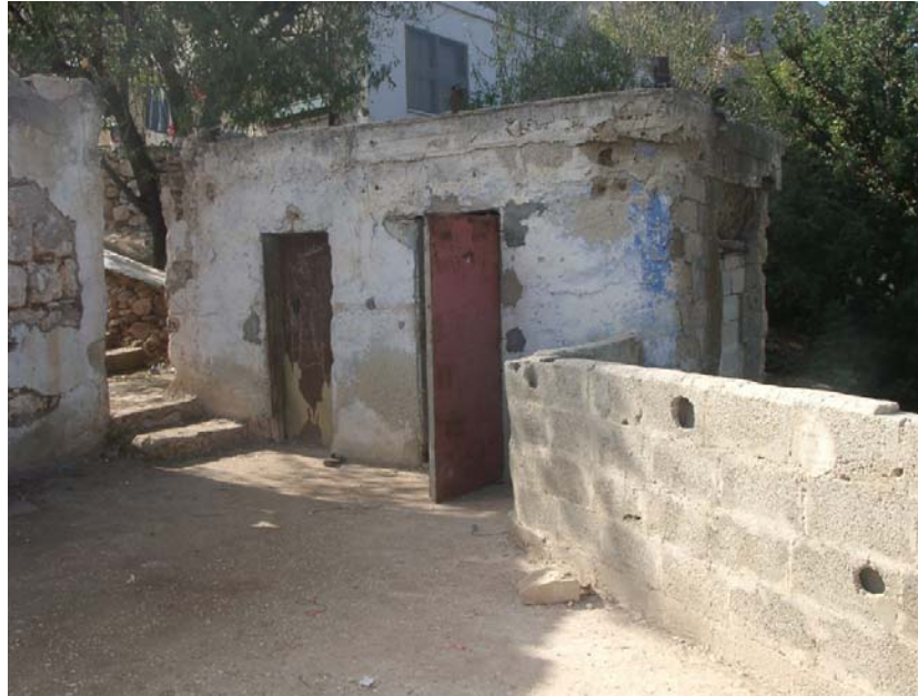
صورة رقم (37:4) وحدة سكنية قديمة.
