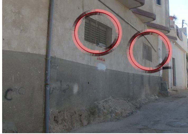
صورة رقم (42:4) حديد الحراسة في الطوابق الأرضية القديمة
