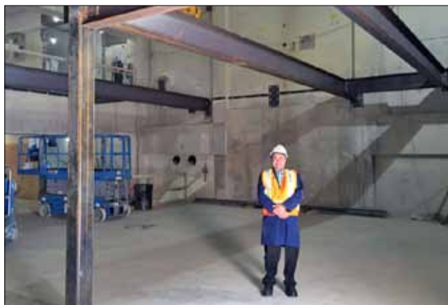
Steelwork for NEL Floors
