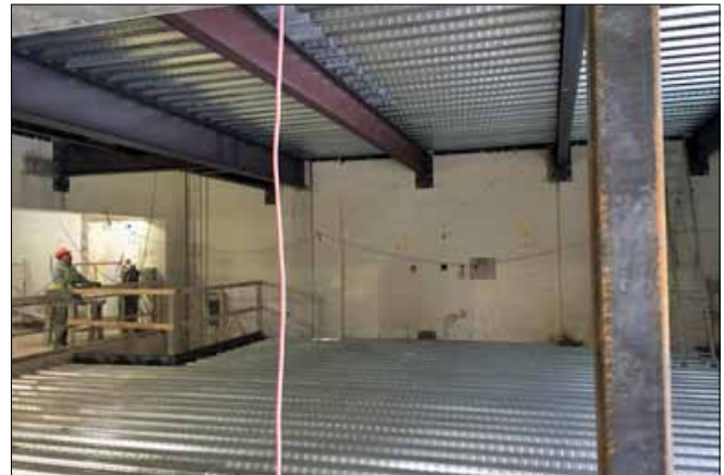
Constructing floors in NEL
